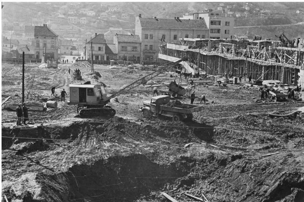
Слика 06. Трг партизана током изградње (1958)
